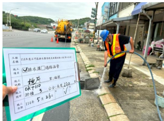
圖二十六水溝清淤工程
