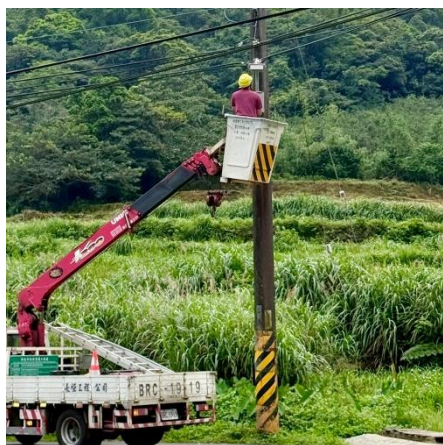
圖二十七路燈工程
